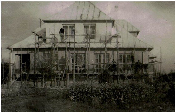
Budowa szkoły w Koszolah 1939 rok.
