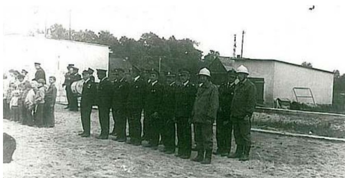
Strażacy OSP Łomazy na placu budowy. Widoczne fragmenty budowanego Domu Strażaka
