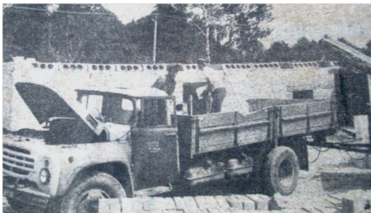
Łomazy, rok 1980. Budowa Banku Spółdzielczego. W tle park.
