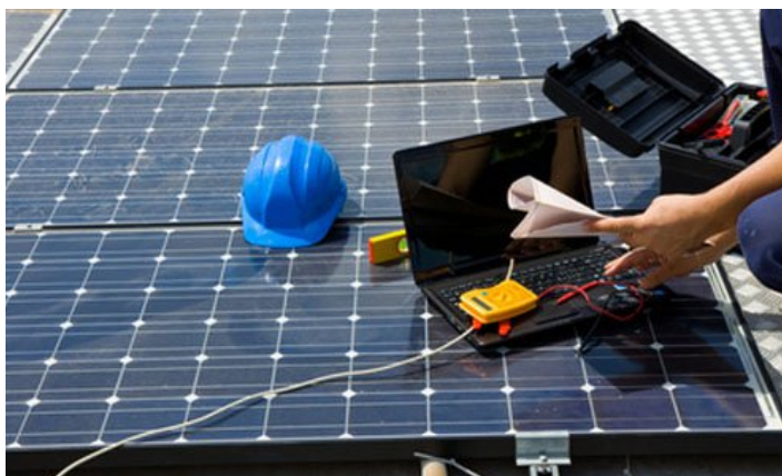
Montaż instalacji fotowoltaicznej fot. Twoja energia
